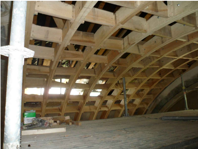
Vista generale dell'orditura lignea principale e secondaria portante
