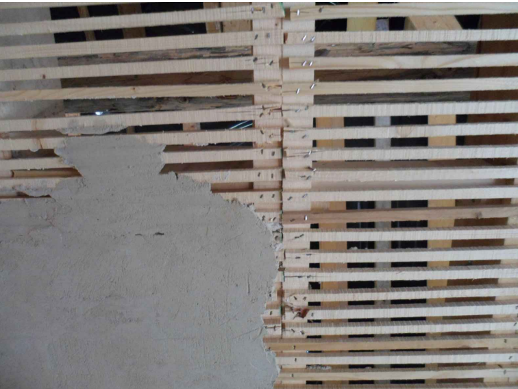
Realizzazione dell'intonaco intradosale su sottostante listellatura lignea di supporto
