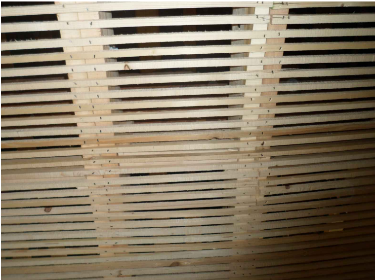
Listellatura lignea di supporto dell'intonaco intradosale
