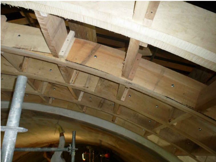
Particolare dell'orditura lignea principale e secondaria portante
