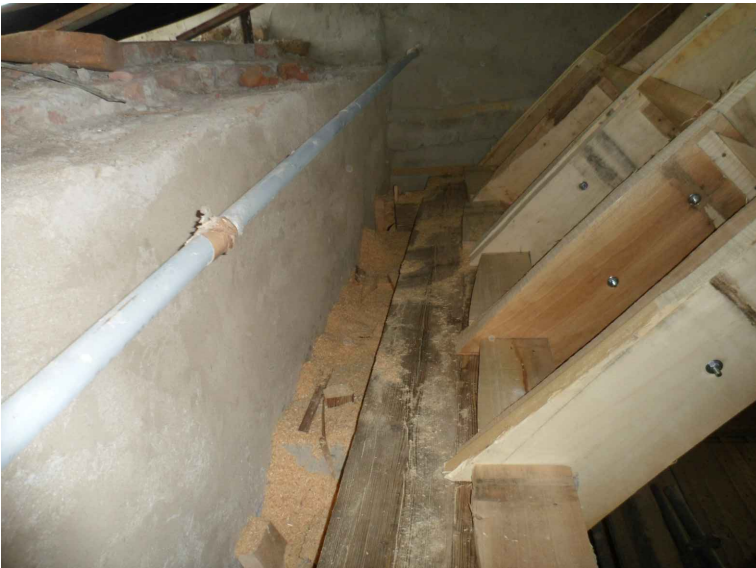
Appoggio del dormiente ligneo sulla cornice in muratura, vista lato muratura esterna
