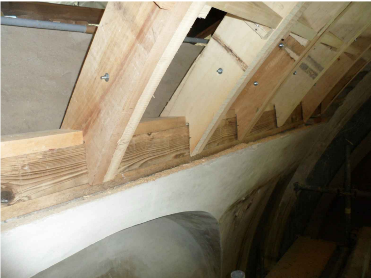
Appoggio del dormiente ligneo sulla cornice in muratura, vista dall'interno dell'aula
